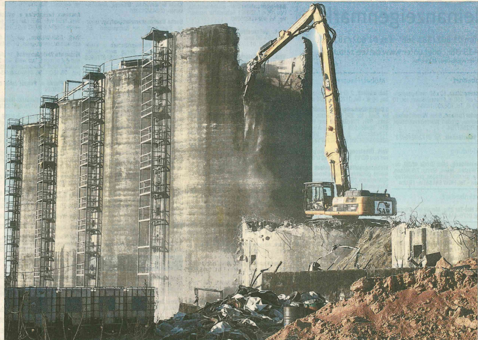
Der vierte von sechs Silos auf dem Gelände der Milchviehanlage in Sagard wird gegenwärtig abgerissen. Der Abbruchbagger mit dem extra langen Greifarm steht auf den verfüllten Stümpfen der bereits abgerissenen Behälter.
