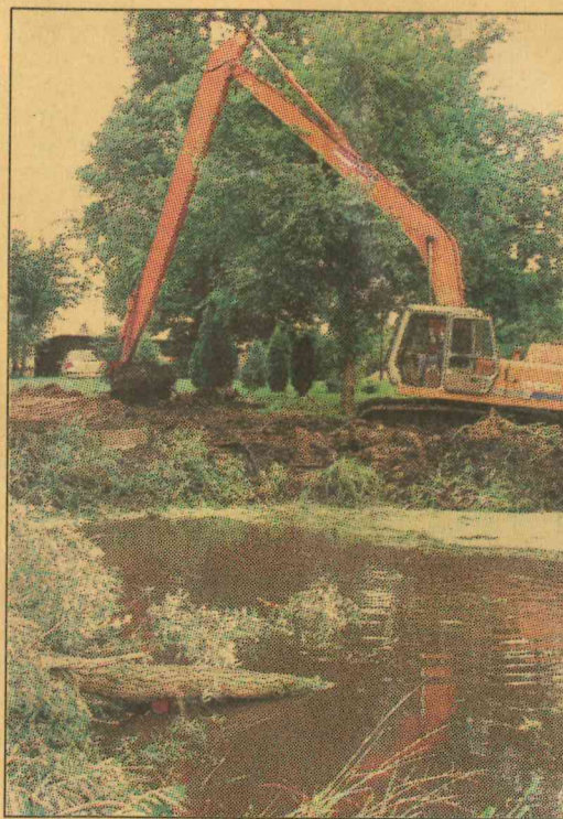
Mit schwerem Gerät sind Mitarbeiter der Firma SAW in Karnitz im Einsatz. Der Teich am Schloss wird saniert. OZ-Foto: U. B.
